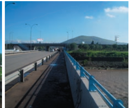
Puente 'el resbalón' hacia renca, al fondo la costanera norte
