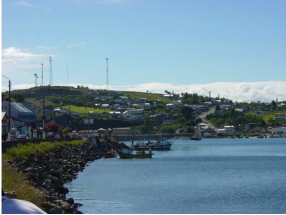
Vista Isla Calbuco y su único acceso desde el continente, el terraplén. (Foto propia)
