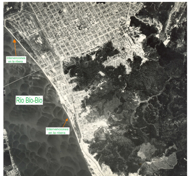
Figura 16: Intervenciones en la ribera del río Bío-Bío.
