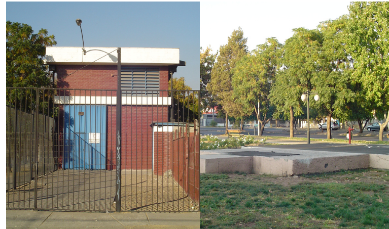
Figura 22: Espacios residuales de resguardo de infraestructura del Metro. Izquierda, subestación eléctrica. Derecha, respiradero.
