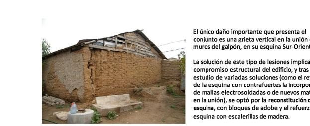
El único daño importante que presenta el conjunto es una grieta vertical en la unión de dos muros del galpón, en su esquina Sur-Oriente.
