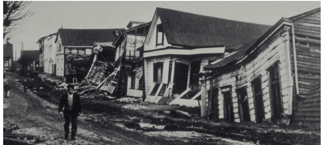
Destrozos en la ciudad de Valdivia por el Terremoto de 1960, National Geophysical Data Center (NGDC)
