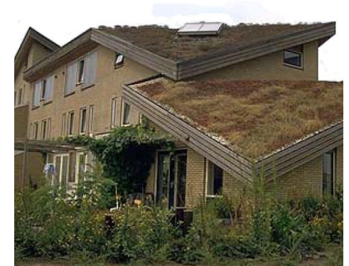
Techumbres vegetadas para la infiltración y reducción de escorrentías superficiales. Holanda. "Criterios de sustentabilidad para la integración de humedales" (2007).
