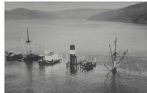
Puerto en Corral después del Tsunami por el Terremoto de 1960, National Geophysical Data Center (NGDC)
