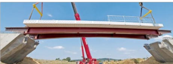
Puente vial en base a perfiles de FRP capas de ser transportado al lugar definitivo y montado en pocas horas. Fuente: www.fiberline.com
