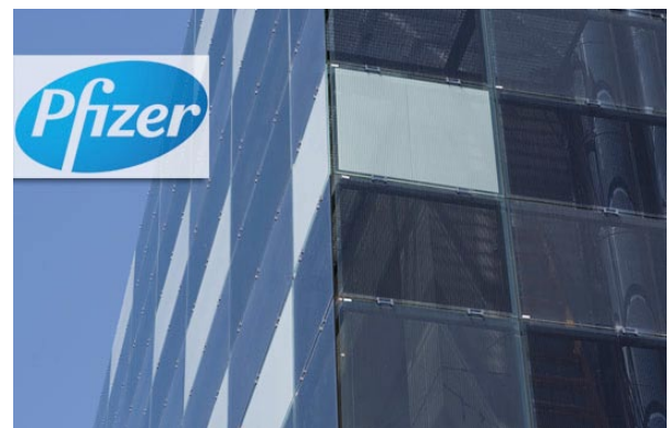
Fachada ventilada fotovoltaica del Centro Pfizer - Universidad de Granada - Junta de Andalucía de Genómica e Investigación Oncológica (GENyO)
