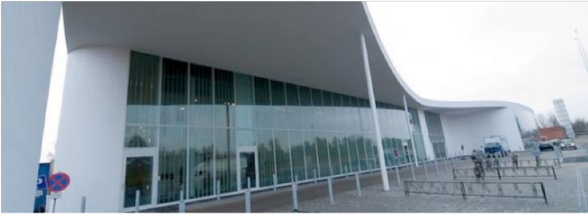
Fachada estructurada con perfiles de FRP. Fuente: www.fiberline.com
