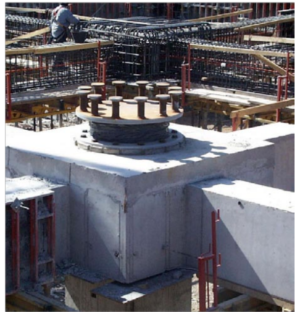
Imagen de un aislador sísmico utilizado en el nuevo Hospital Militar. Fuente: Arquitectura MOP
