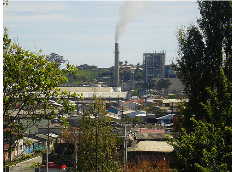
Imagen 3.6 Termoeléctrica Bocamina, ubicado en la población Aroldo Figueroa y Capitán Cabrejo, Fuente: www.coronelb.cl
