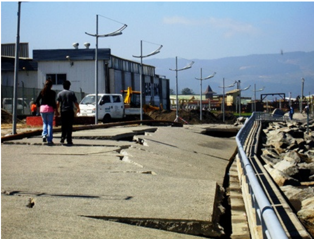
Imagen 7.2 Sector Paseo Las Olas, Terremoto 27 de febrero 2010.
