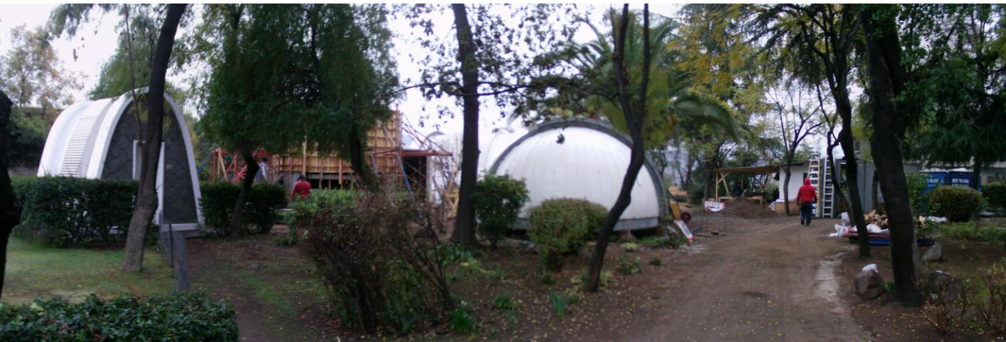
Cúpula en construcción para nuevo telescopio estudiantil.
