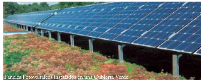
Paneles Fotovoltaicos instalados en una Cubierta Verde.
