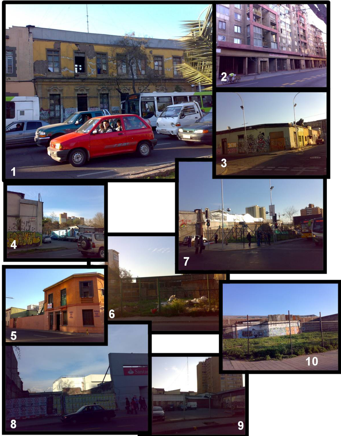
Figura 23. Fotos tomadas en terreno que muestran el deterioro del entorno del Edificio Lord Cochrane: (1) Deterioro infraestructura sector Avda. Matta, al poniente de Lord Cochrane; (2) Infraestructura abandonada San Diego con Santa Isabel; (3) Deterioro vivienda Aldunate con Aconcagua; (4 y 5) Venta de propiedades deterioradas (Santa Isabel con Aldunate y Lord Cochrane con Aconcagua, respectivamente); (6, 7, 8, 9 y 10) Sitios eriazos que muestran el latente fenómeno del “Efecto Picarón” en el área central de la ciudad (Copiapó con Lord Cochrane, San Diego con Copiapó, San Diego con Diez de Julio, Aldunate con Copiapó y Lord Cochrane con Avda. Matta, respectivamente).
