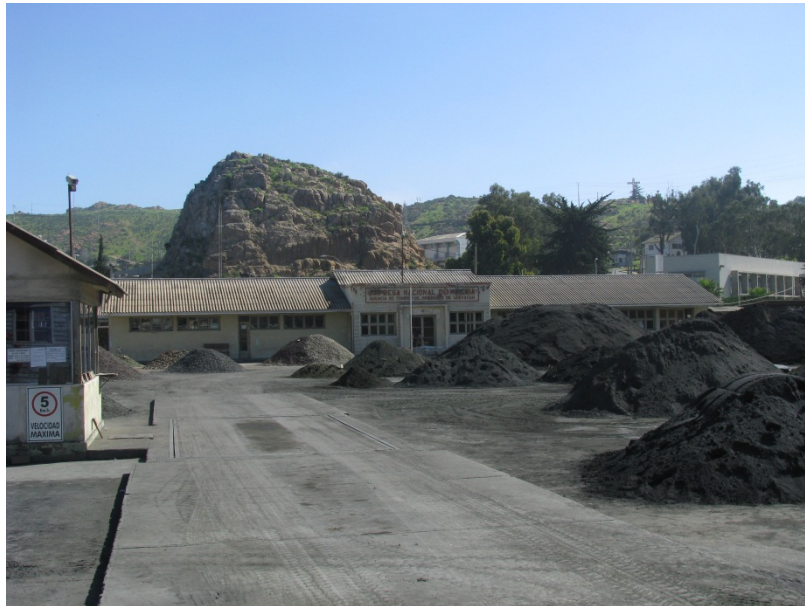
44. Vista C: ex casona ENAMI ubicada en la terraza inferior del terreno. Fuente: Elaboración propia
