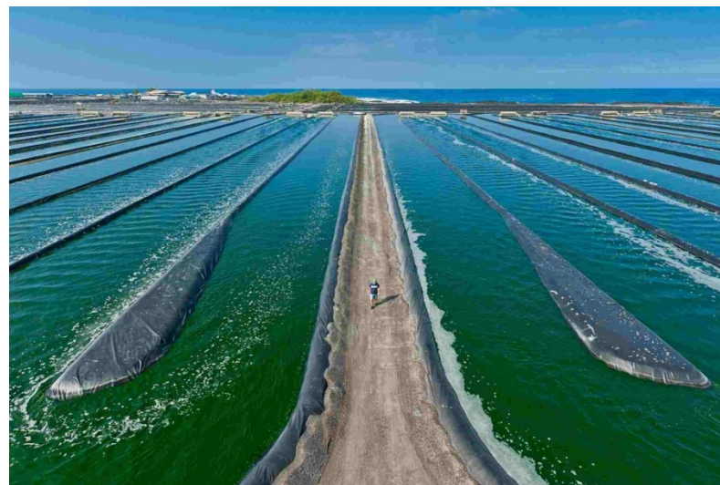
27. Instalaciones industriales outdoor tipo raceway para biodiesel de algas.
