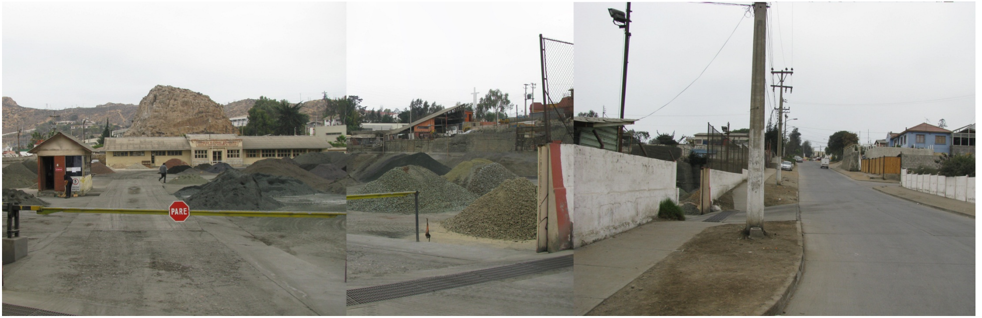
42. Vista A: terraza inferior del terreno.
