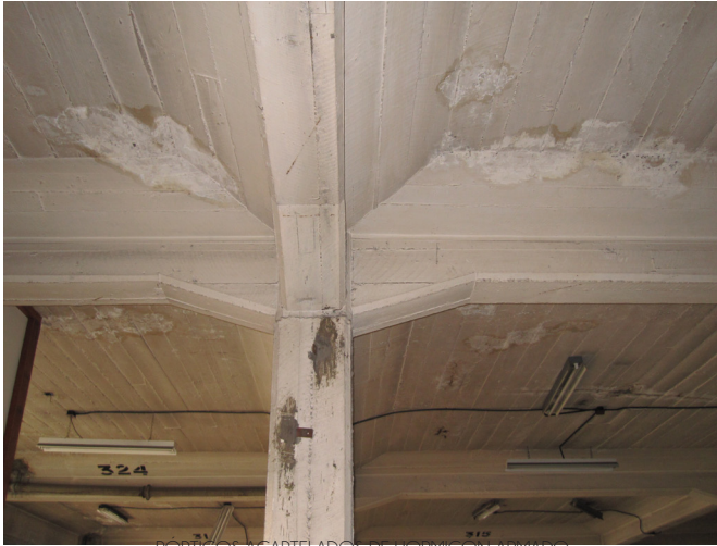
PORTICOS ACARTELADOS DE HORMIGÓN ARMADO FUENTE: ELABORACIÓN PROPIA
