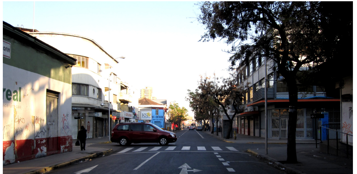
IMAGEN: ALTURA DE EDIFICACION, CALLE CHACABUCO FUENTE: ELABORACIÓN PROPIA
