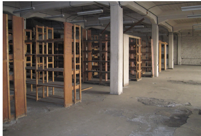
USO ACTUAL DEPENDENCIAS DE PERSONAL EDIFICIO DICREP FUENTE: ELABORACIÓN PROPIA
