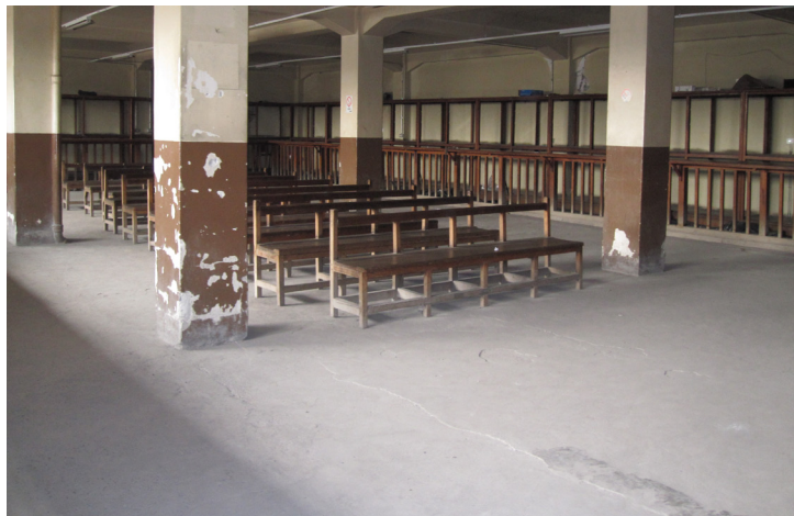
USO ACTUAL ZONA DE REMATES EDIFICIO DICREP FUENTE: ELABORACIÓN PROPIA
