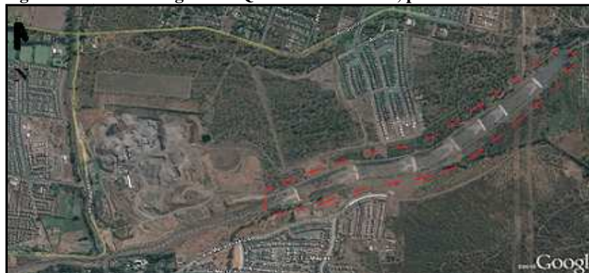
Imagen N° 2: Obra mitigación / Quebrada de Macul, piscinas control aluviones.
