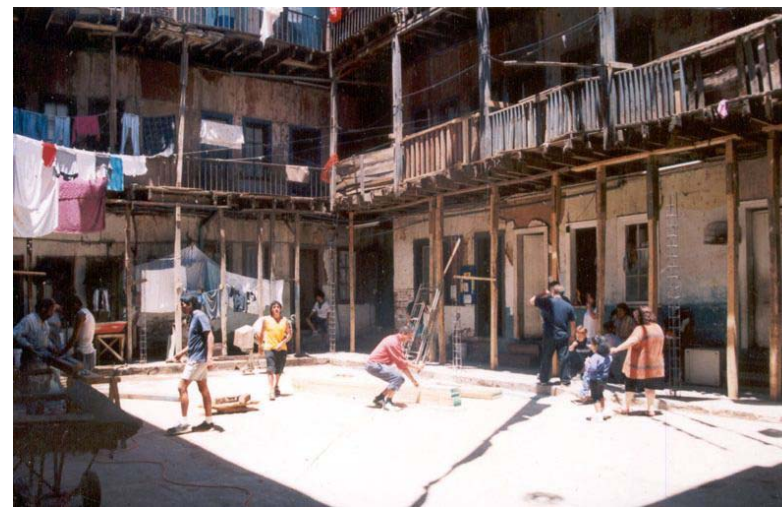
Imagen 40 a 42. Rehabilitación del Edificio de la Población obrera de la Unión. Este es el primer esfuerzo en Chile por rehabilitar un inmueble para vivienda social (para sus propios ocupantes originales), lo cual es paradójico, pues se trata del primer edificio construido para albergar a obreros y sus familias a fines del siglo XIX.
