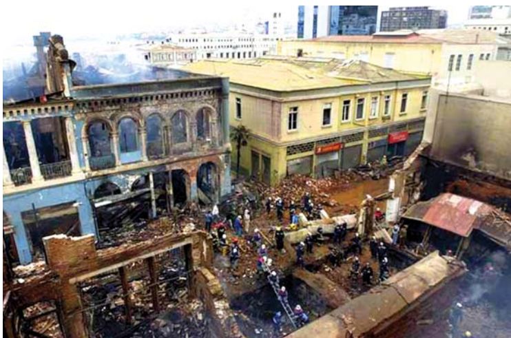
Imagen 10. La explosión de gas en la calle Serrano en enero del 2007, pone de manifiesto el deterioro paulatino que está afectando a la ciudad de Valparaíso debido a su despoblamiento.
