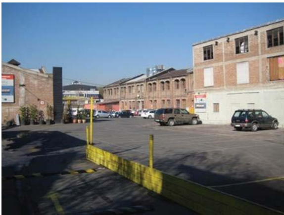
Arriba y abajo: interior complejo, vistas hacia Av. Bilbao (arriba) y hacia la calle Luis Montaner (abajo)
