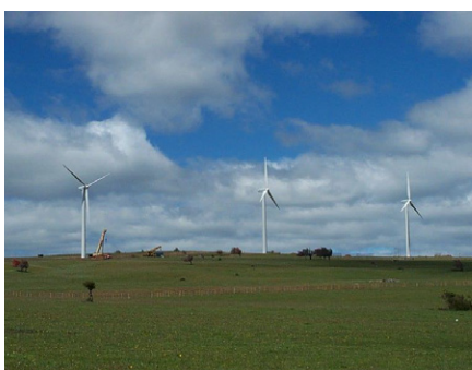
Central Alto Baguales, Coyhaique. Posee 3 aerogeneradores de 660kV y una potencia total de 2 MW, equivalente al 16% de la demanda en el Sistema Aysén. (Fuente: material de apoyo de Windservice – Energía Eólica)
