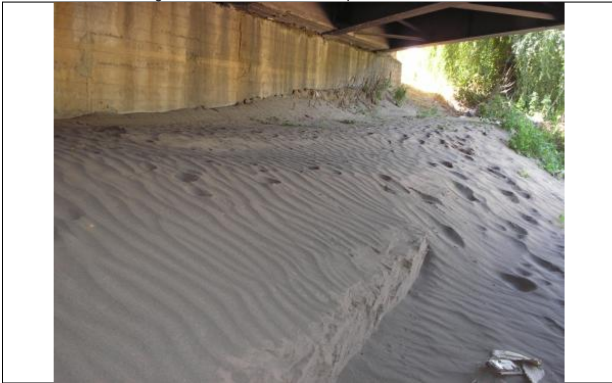
Imagen N° 2 “Evidencia de la Deposición de Arenas”
