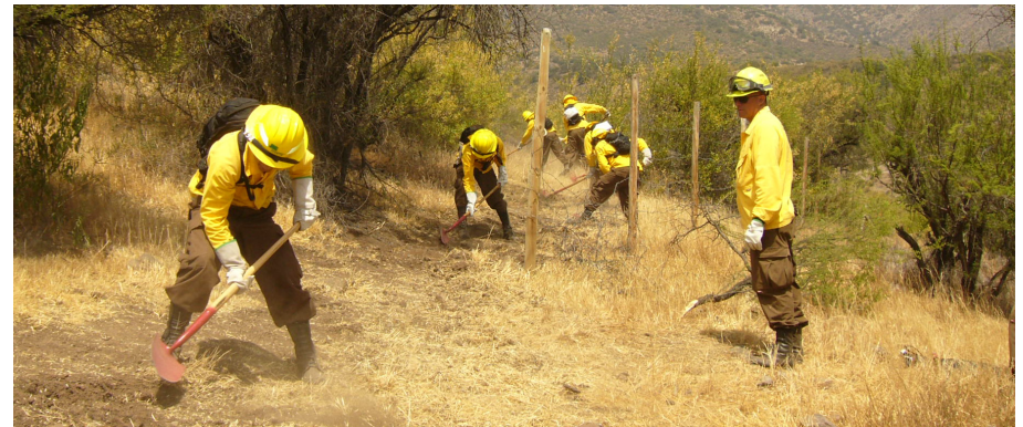
Fig. 36 Construyendo línea de fuego
