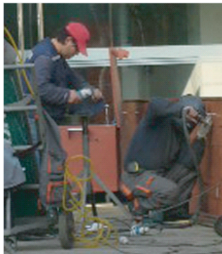
Fig. 21 Sistemas de agarre improvisados
