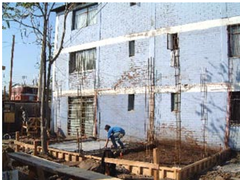
Foto N°36 Proceso constructivo del mejoramiento habitacional
