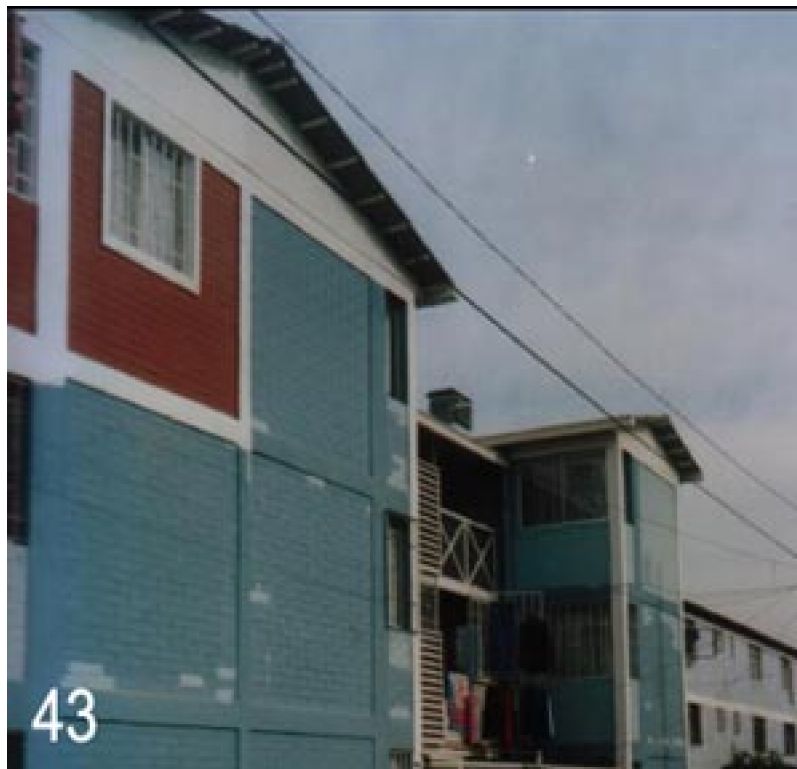
Foto N°43 Muestra viviendas todavía sin ampliaciones agregadas
