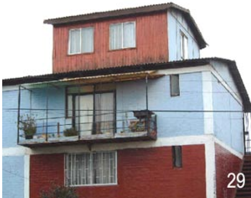
Foto N°29 Ampliación y transformación realizada por los habitantes en segundos y terceros pisos
