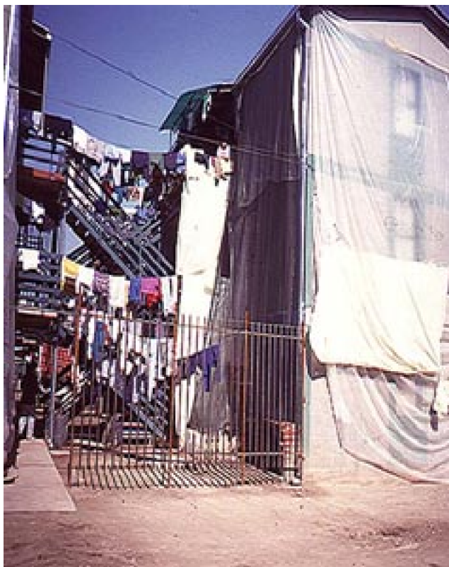
Foto N°11 Espacio entre naves. Apropiación por parte de los habitantes
