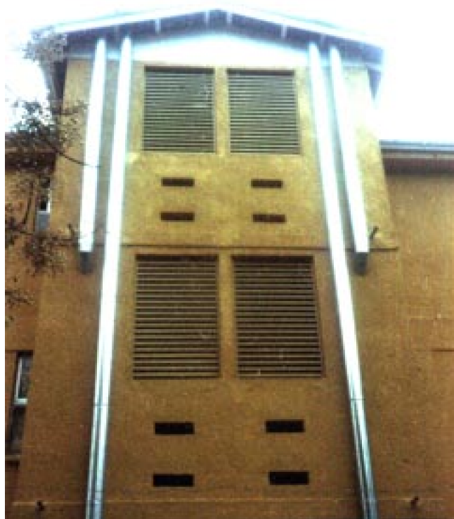
Foto N°22. Población Parinacota. Ampliación terminada
