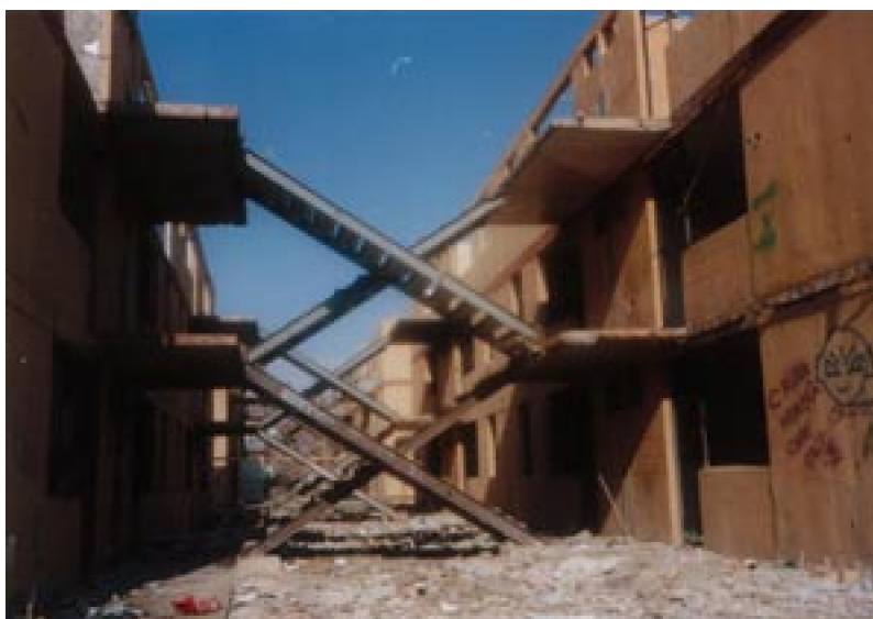
Foto N°28. Población El Volcán. Estado en que se dejan las viviendas
