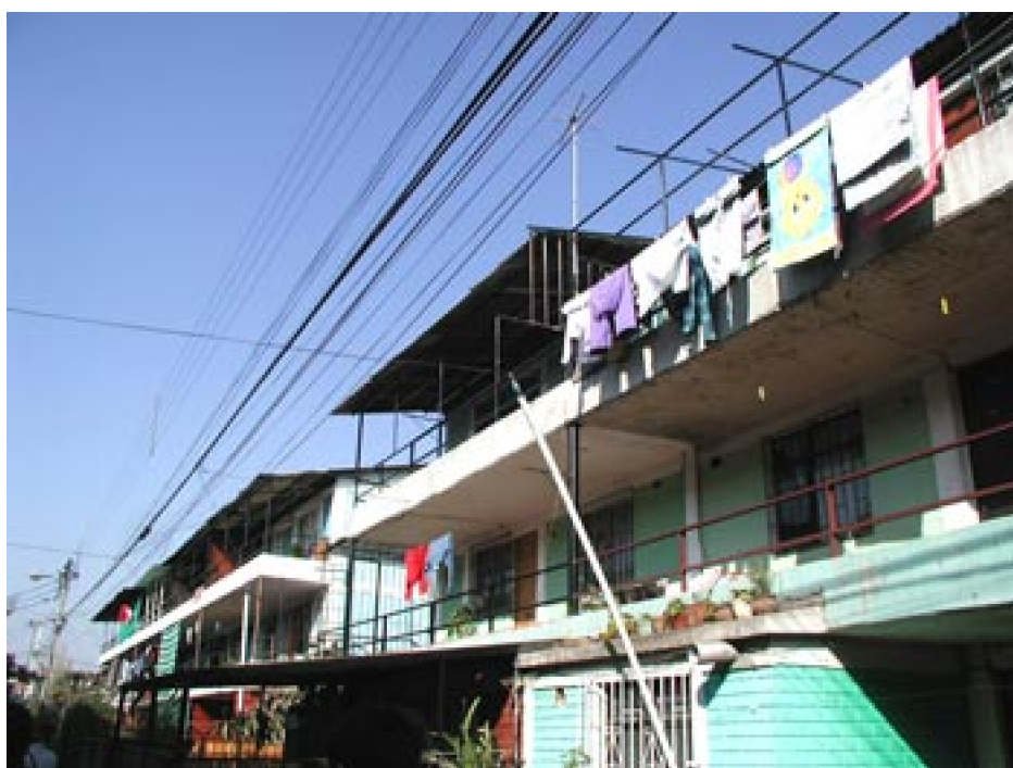
Foto N°4. Población Los Quillayes. Ampliaciones en tercer piso.
