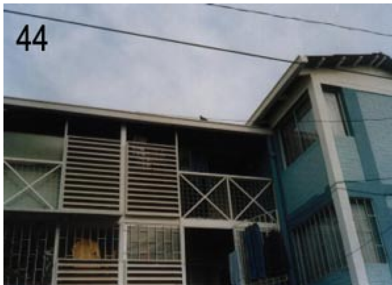
Foto N°44 Muestra viviendas todavía sin ampliaciones agregadas
