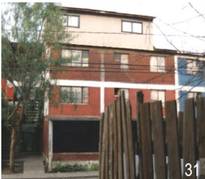
Foto N°31 Ampliación y transformación realizada por los habitantes en segundos y terceros pisos
