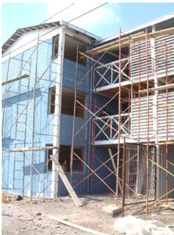
Foto N°38 Proceso constructivo del mejoramiento habitacional
