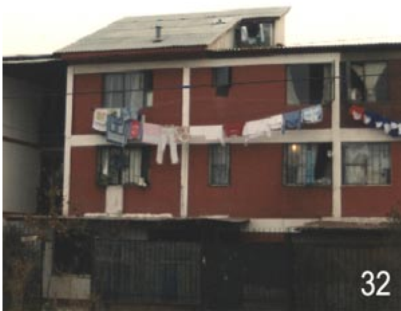
Foto N°32 Ampliación y transformación realizada por los habitantes en segundos y terceros pisos
