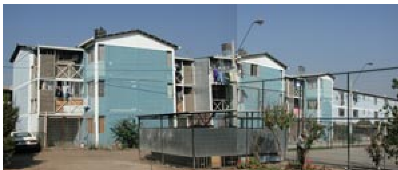
Foto N°41 Estado actual del bloque intervenido
