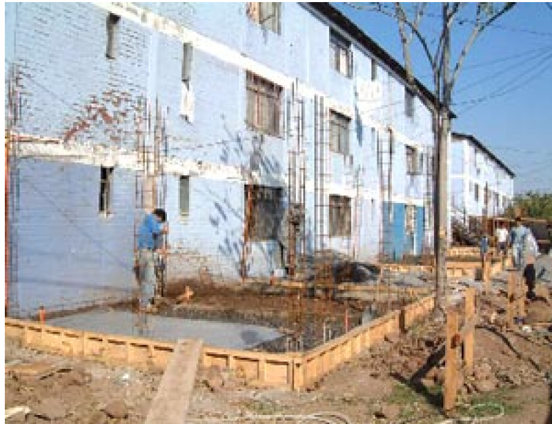
Foto N°35 Proceso constructivo del mejoramiento habitacional
