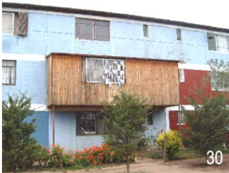
Foto N°30 Ampliación y transformación realizada por los habitantes en segundos y terceros pisos
