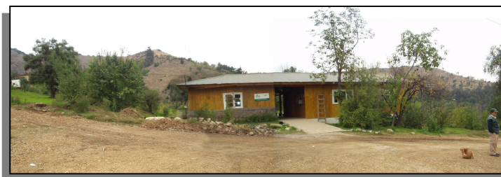
CASA PATAGUA Antigua escuela agrícola pública reacondicionada para oficinas administrativas.
