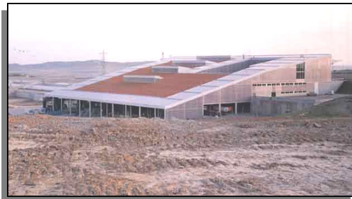
Centro de reciclaje en Valdemingómez, Madrid
