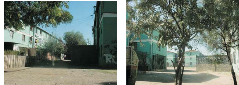
Vista de los espacios entre bloques
