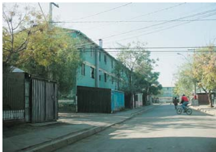
Vista desde las vías longitudinales
