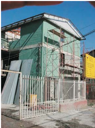
Foto rehabilitación SERVIU en población
