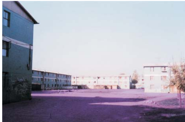
Vista de un caso de patios interiores
