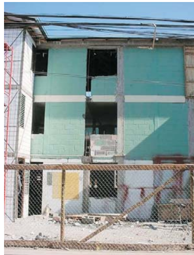
Foto rehabilitación SERVIU en población
