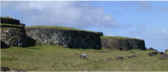
Construcción en piedra de Orongo .
