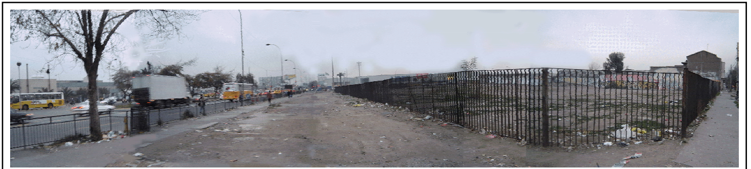
Fig. 3.-Vereda Norte de la Alameda
