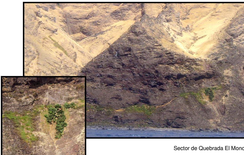
FOTOGRAFÍA N° 5: AFLORAMIENTOS DE NAPAS SUBTERRÁNEAS
