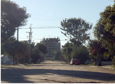
Nuevas construcciones_ Sector El Canel
