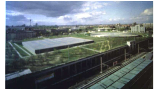
Velódromo y Piscina Olímpicos en Berlín. Arquitecto Dominique Perrault.
