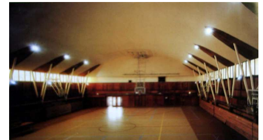
Gimnasio colegio Calasanz. Arquitectos Teodoro Fernández y Sebastián Hernández.
