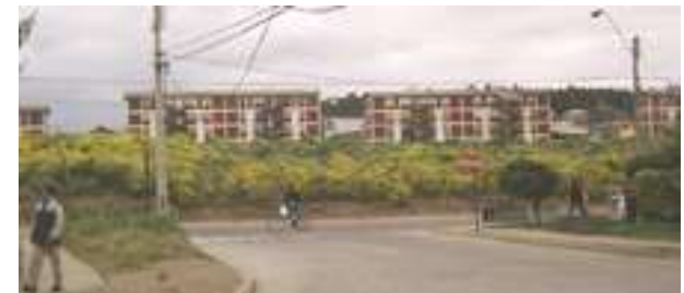
Vista desde Av. Manantiales del talud y los bloques de vivienda social.
