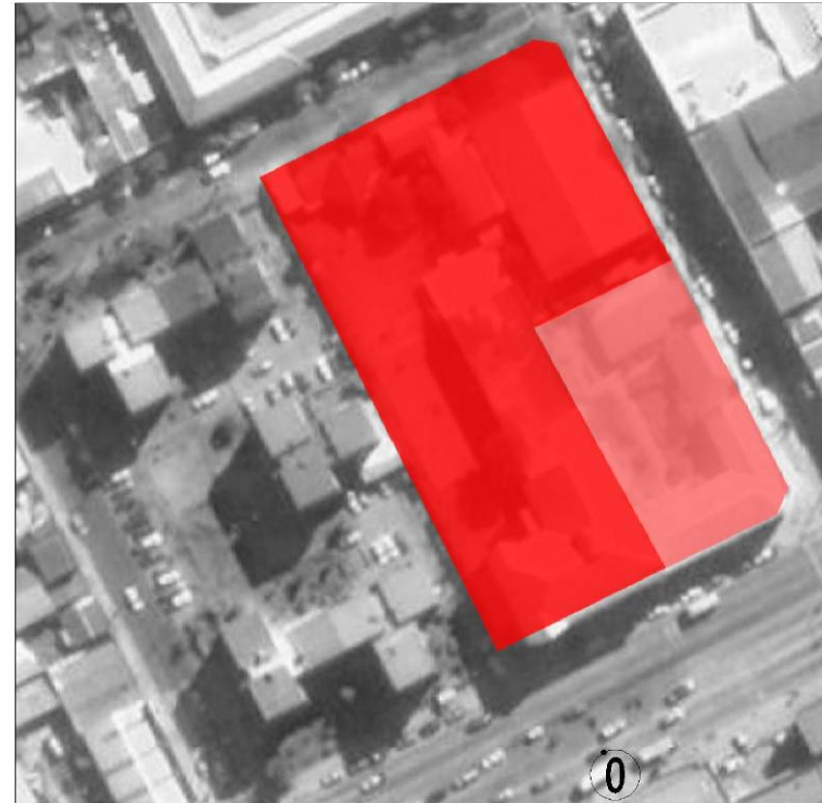
Imagen extraída de Google Earth, posteriormente intervenida.
