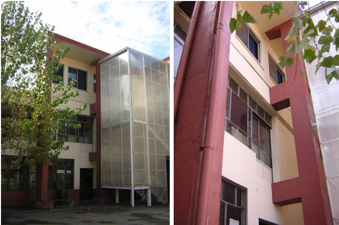
4. Imagen del autor. Estructura auxiliar de ampliación.
