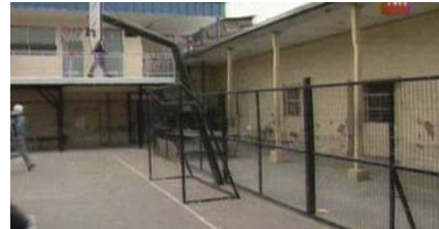
Estructura: improvisada para aumentar cobertura educacional
