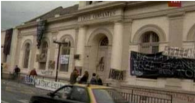
Fachada: acceso de comunicación directa con una vía de alto transito vehicular
