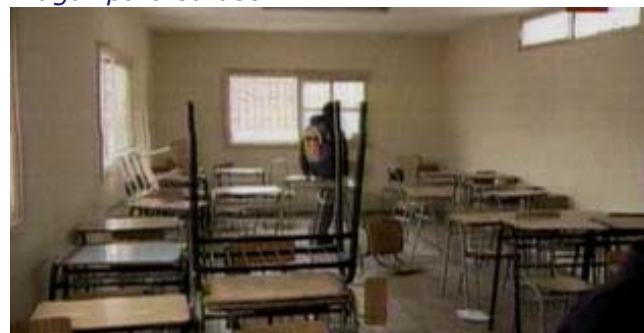
Falta de mantención de la infraestructura
