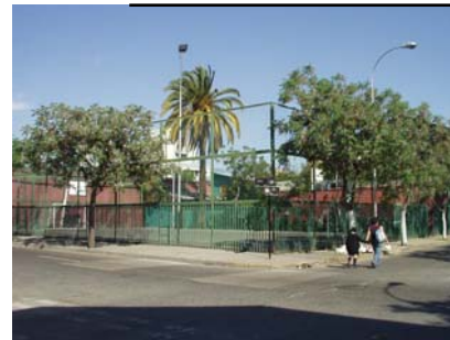
Abertura de esquinas
