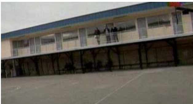
Estructura: improvisada para aumentar cobertura educacional
