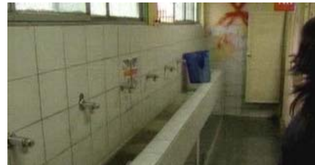
Baños: problemas de filtraciones de agua falta de artefactos y mantenimiento
