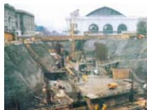
Construcción Estación Metro Cal y Canto
