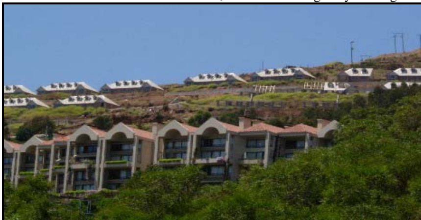
Foto 7. Construcción sobre las terrazas, costa entre la laguna y Cachagua
