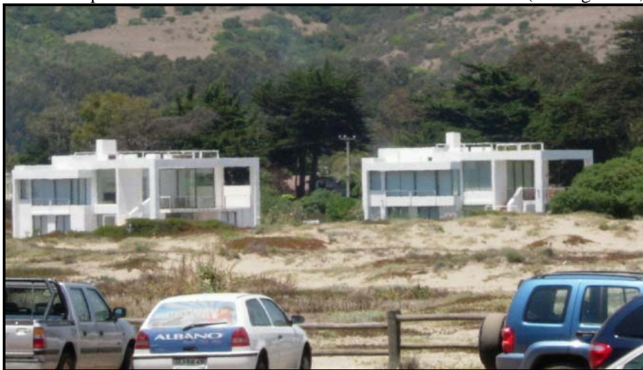
Foto 2. Emplazamiento de viviendas sobre dunas no estabilizadas. (Cachagua sur, 2006).
