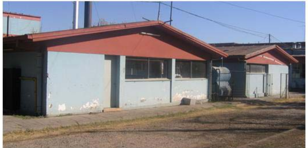
Fachada norte, bodega.
