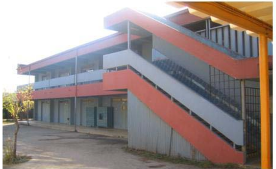
Fachada sur, pabellón norte.
