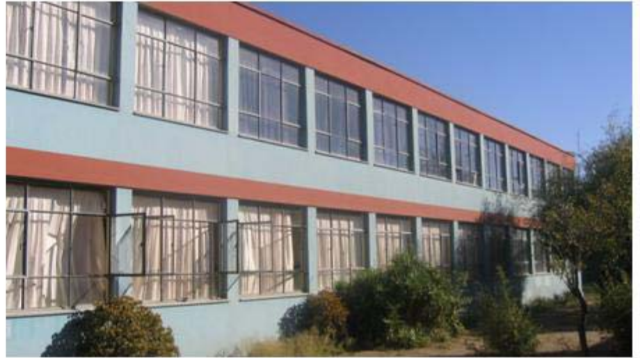
Fachada norte, pabellón norte.
