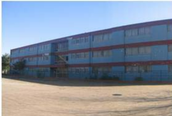
Fachada oriente, pabellón internado.
