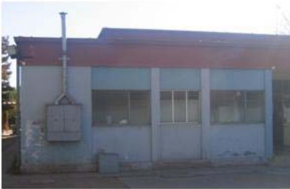
Fachada oriente, cocina.
