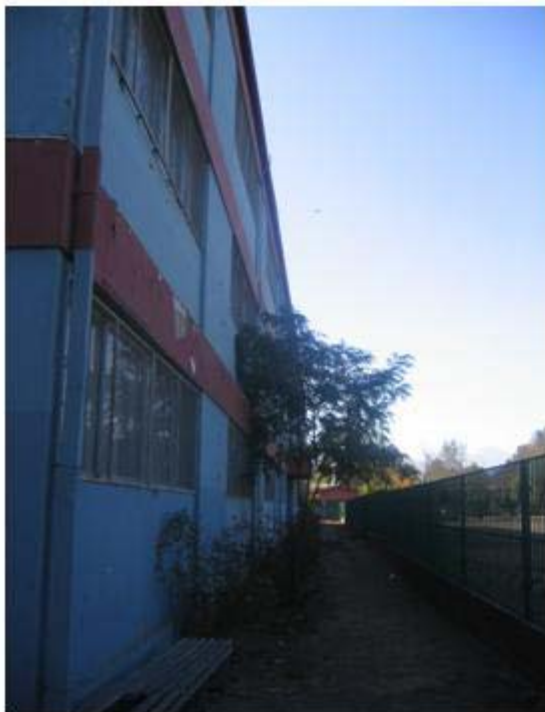
Fachada oriente, cierre con reja, internado.
