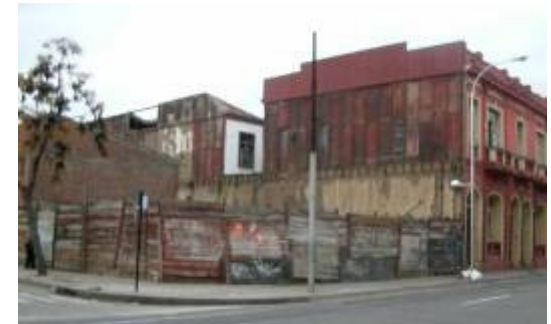
Deterioro y abandono en Santiago Poniente. Foto: autora.
