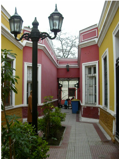
Nueva imagen del Cité Recreo, barrio Yungay, tras la intervención del Programa de Rehabilitación Habitacional. Foto: autora.
