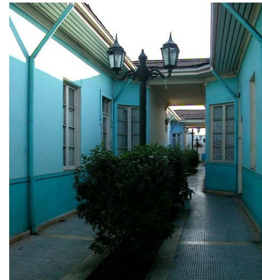
Antes y después de las intervenciones del Programa de Rehabilitación Habitacional, en el Cité Gustavo Monckeberg, barrio Estación Central. Foto: autora.
