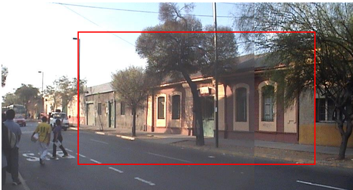
Fachadas de Ambos terrenos
