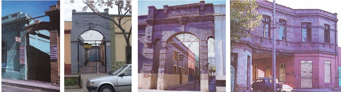
Variedad de pórticos de acceso
