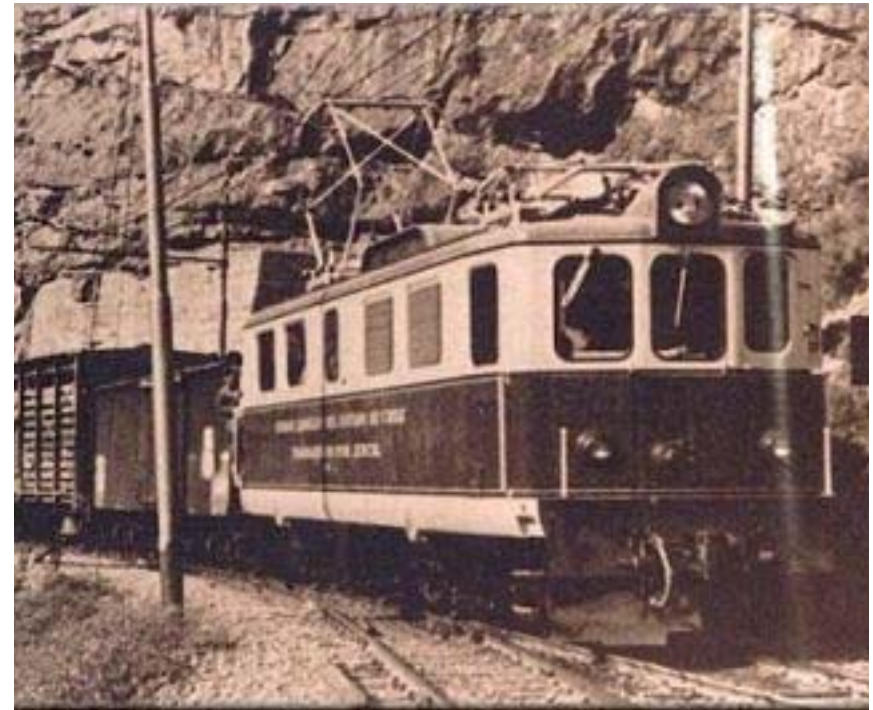
Imagen N°2 . Locomotora clase 200 arrastrando un tren de carga el "Cruce del Km 44".
