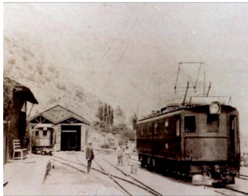
Imagen N°2. Locomotora clase 200 arrastrando un tren de carga el "Cruce del Km 44"
