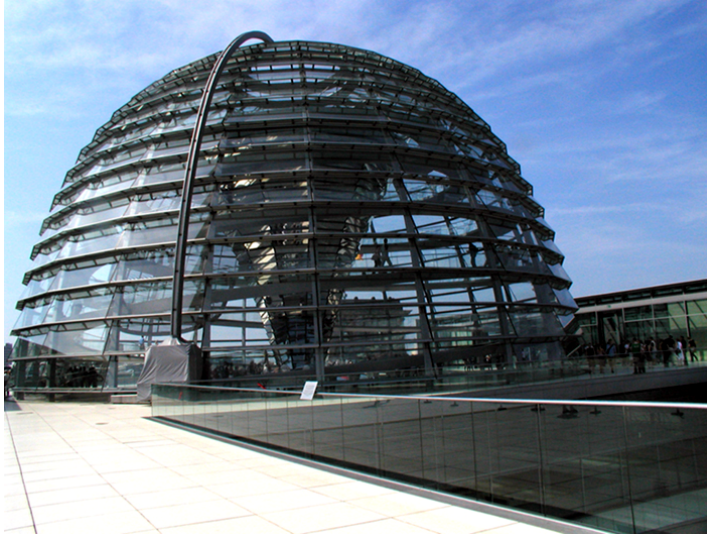
Parlamento alemán climatización geotérmica
