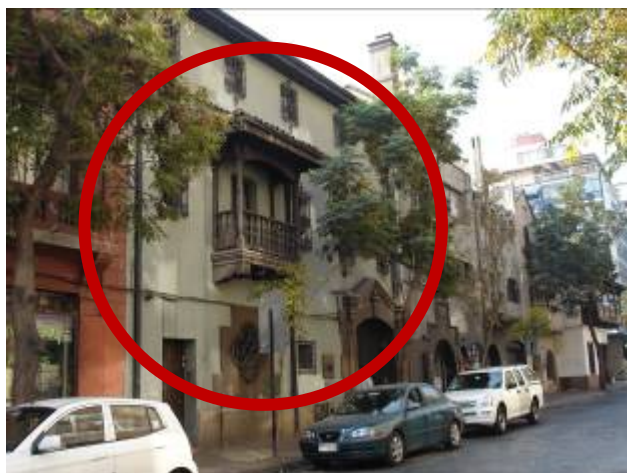
Fig. 26 Fachada norte Hacia Avenida Ismael Valdés Vergara
