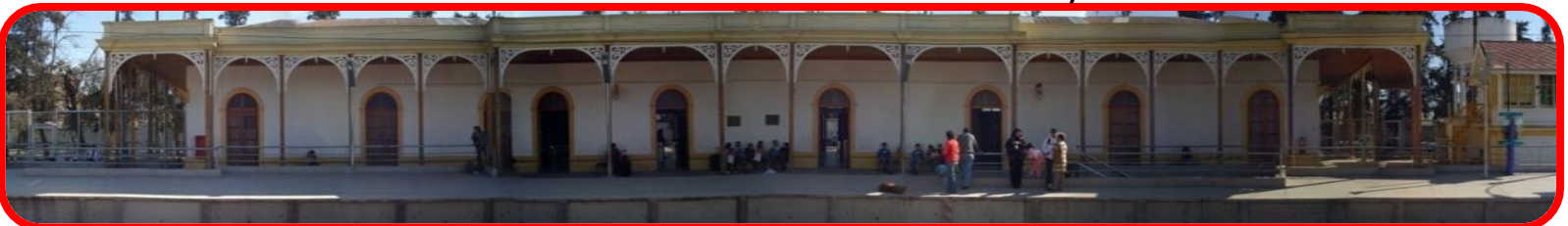
Estación FFCC. San Bernardo
