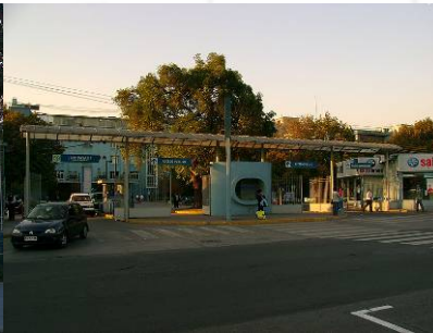
Acceso principal al hospital
