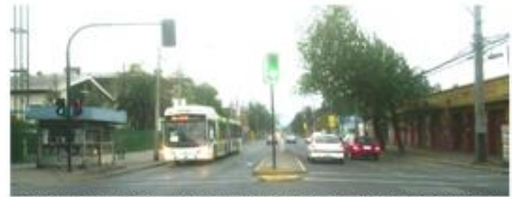
Perfil Recoleta_ Muñoz Gamero, construcción continua deteriorada, de uso comercial y de 1 piso
