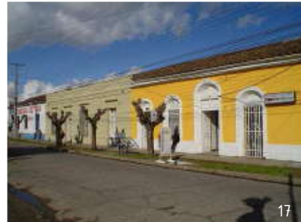
Fachada edificación particular Maipú
