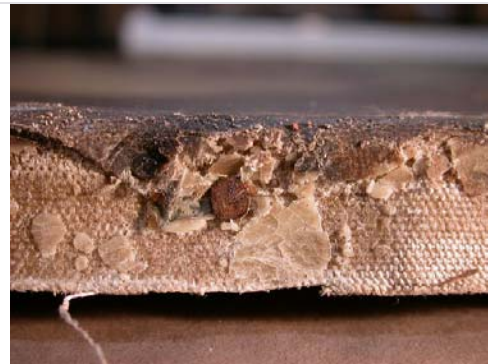
• Obsérvese dos tipos de clavos oxidados y mal colocados.
