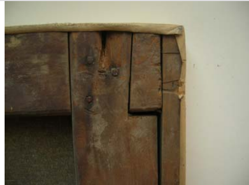
• Detalle de una de las esquinas: Obsérvese los clavos, el faltante y los tres elementos constituyentes del bastidor.
