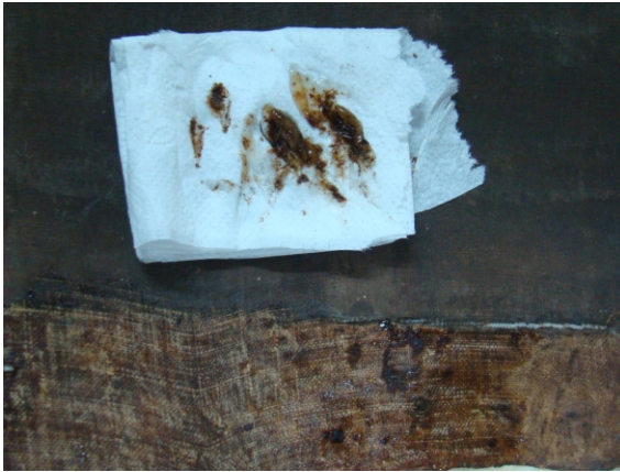
• Fig. 40. Limpieza perímetro, nótase la cantidad de suciedad que se retira
