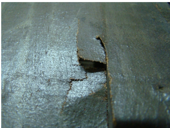
• Fig. 21. Rasgado por causado por un travesaño
