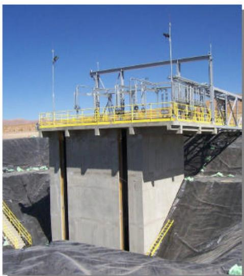
El proyecto consistió en la excavación y construcción de una Torre de hormigón de dimensiones 7,0 x 9,30 x 12,5 m., la que soportará las bombas que recirculan las aguas provenientes de la laguna de relaves de regreso al proceso de producción.
