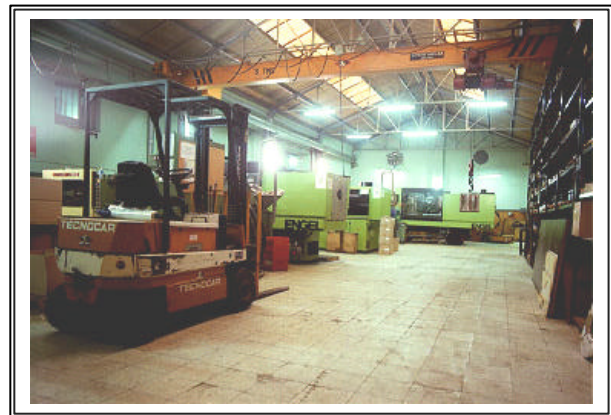
Figura 2. Zona de Almacenamiento
