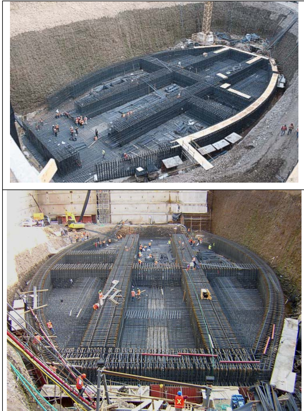
Figura 5.15. Armaduras y excavación en faenas de fundaciones. Edificio Titanium La Portada. Fuente: http://www.titaniumlaportada.cl .
