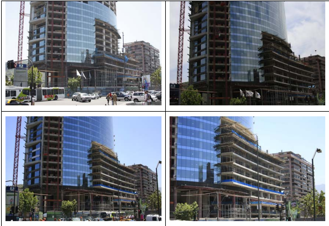
Figura 5.23. Anexo del edificio Titanium en proceso constructivo, de izquierda a derecha, de arriba abajo.
