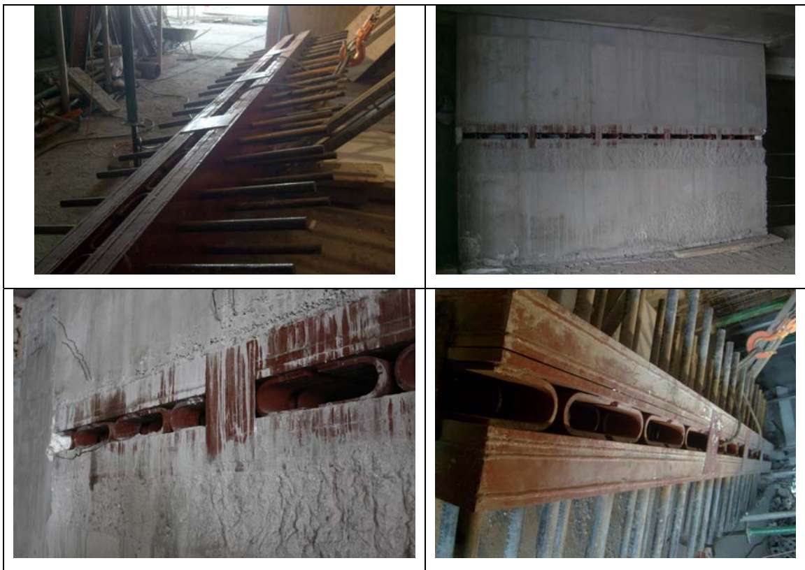
Figura 5.21. Disipadores de energía mediante mecanismos de fluencia dispuestos en dirección longitudinal (oriente-poniente). Edificio Titanium La Portada.
