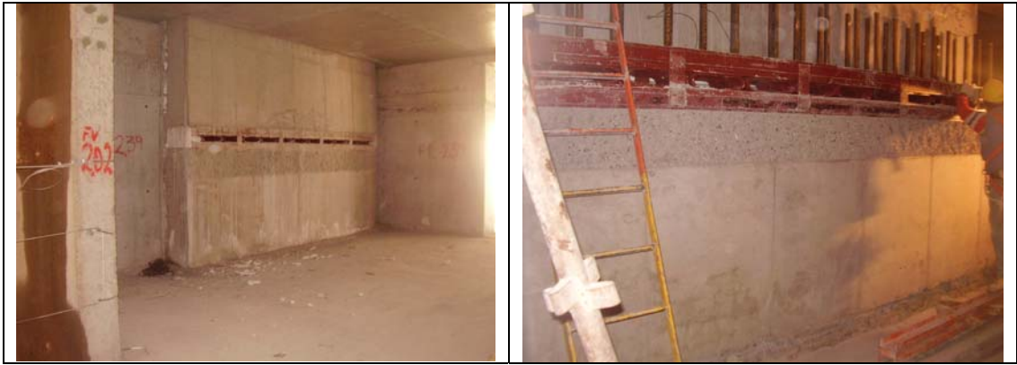
Figura 5. 20. Disipadores de energía mediante mecanismos de fluencia dispuestos en dirección longitudinal (oriente-poniente). Edificio Titanium La Portada.
