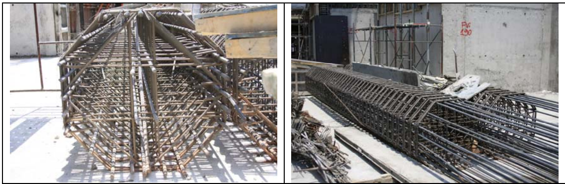
Figura 5.13. Armadura de sección octogonal, para columnas perimetrales, edificio Titanium La Portada.
