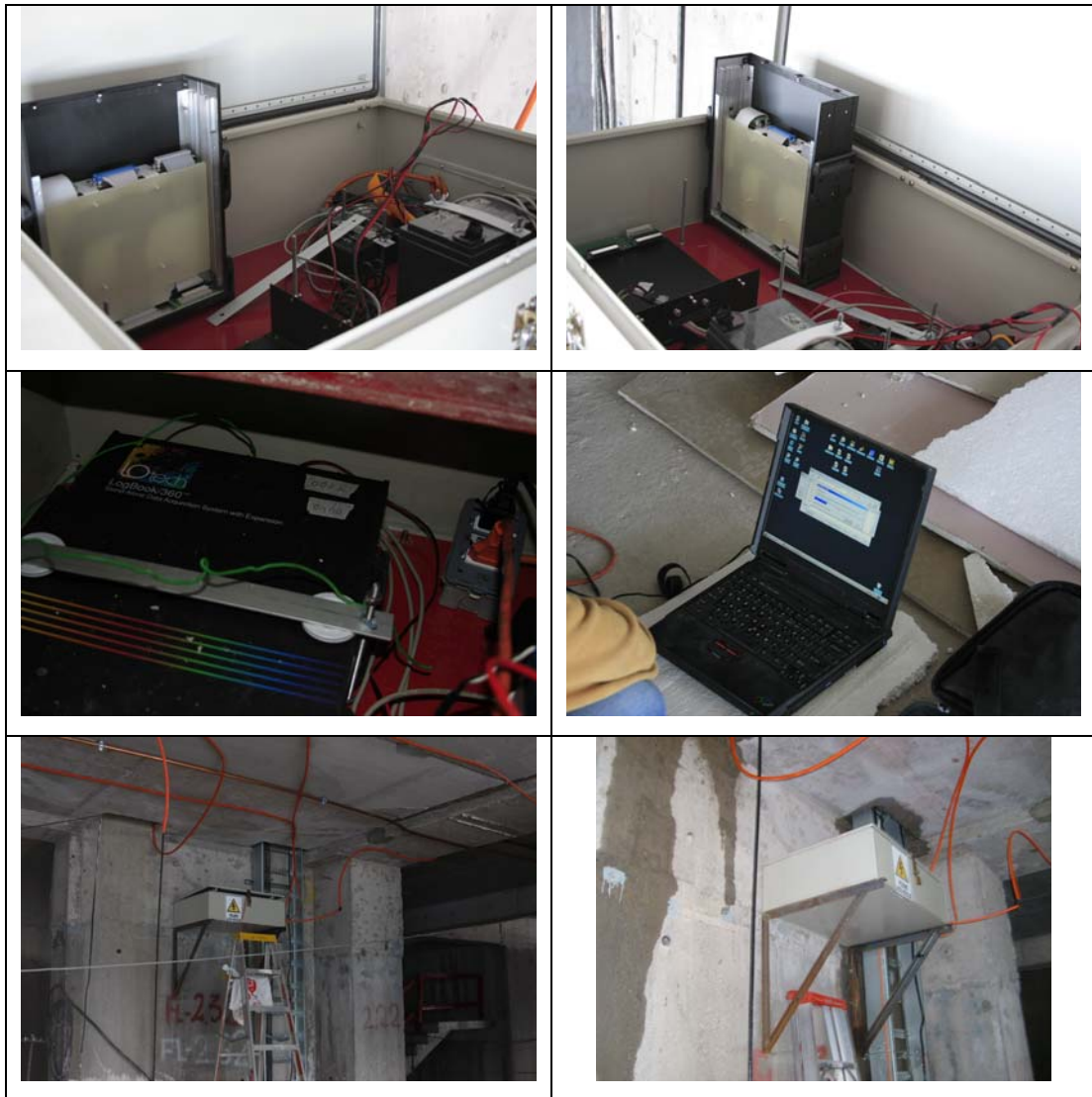
Figura 5. 55. Sistema de adquisición de datos. Edificio Titanium La Portada. Piso 20 Fecha: 13 de Agosto 2008.
