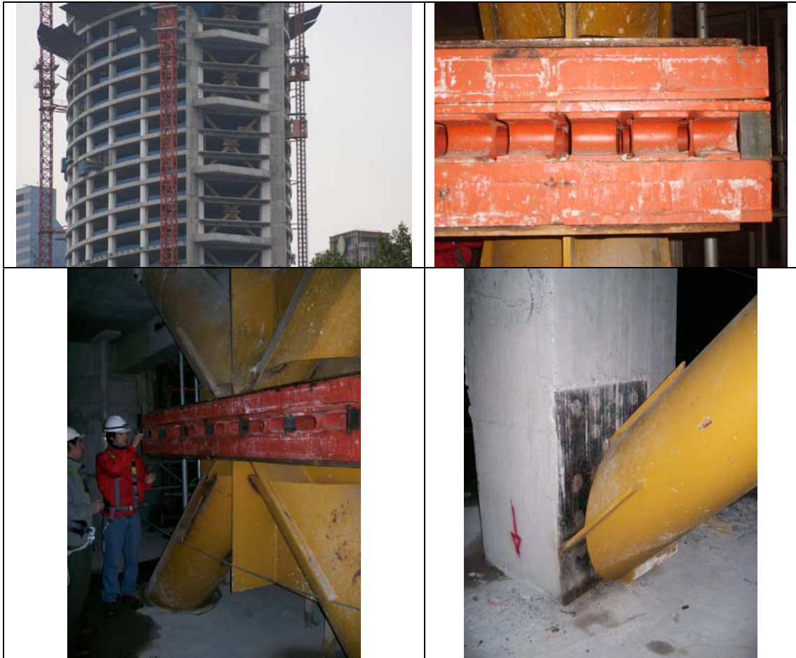
Figura 5.18. Disipadores de energía mediante mecanismos de fluencia dispuestos en dirección transversal (norte-sur). Edificio Titanium La Portada.
