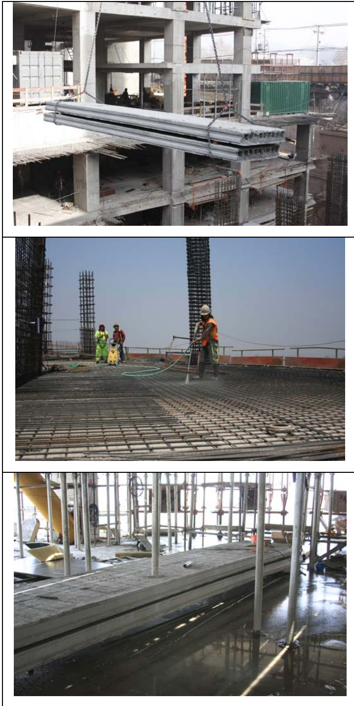
Figura 5.16. Losetas alveolares prefabricadas pretensadas. Armado de losas. Edificio Titanium La Portada.
