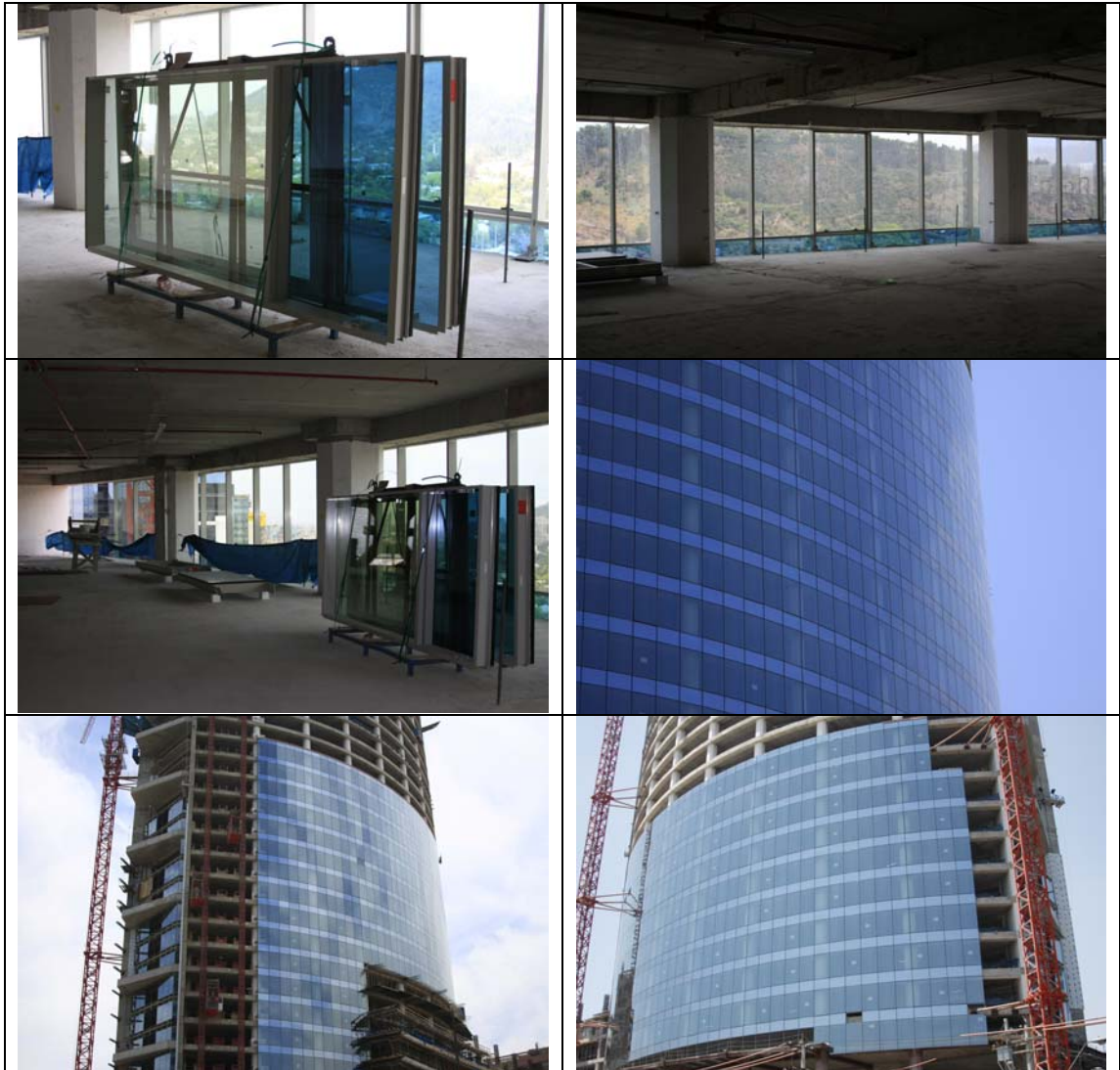
Figura 5.22. Detalles y vistas generales colocación de Muros Cortina. Edificio Titanium La Portada.
