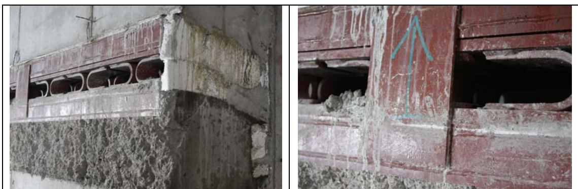
Figura 5.19. Disipadores de energía mediante mecanismos de fluencia dispuestos en dirección longitudinal (oriente-poniente). Edificio Titanium La Portada.
