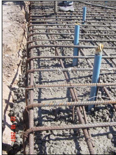
Fig. 4.10: Vista de losa de hormigón en construcción y formación de las perforaciones para anclajes.
