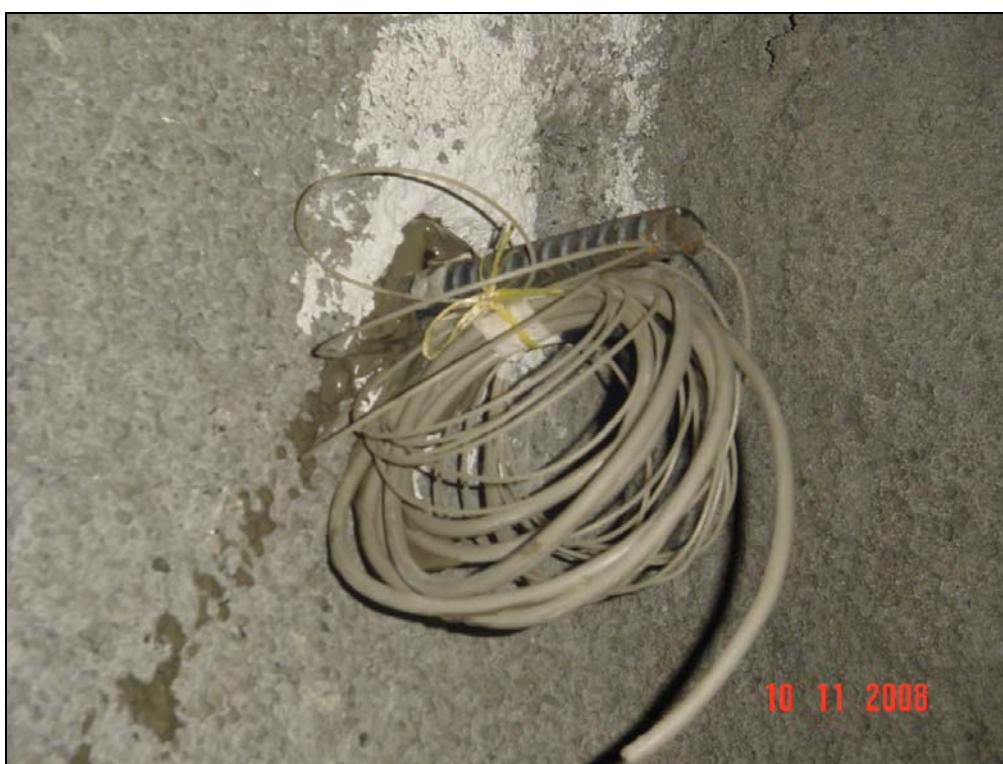
Fig. 4.17: Perno instalado (completamente grouteado) en túnel mina El Teniente.
