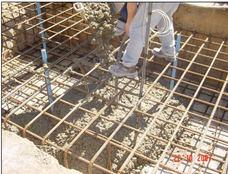
Fig. B. 2: Hormigonado losa. Vista 1.
