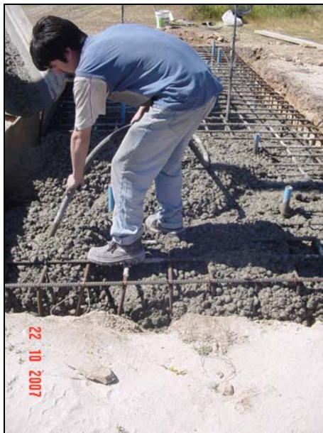
Fig. B. 4: Hormigonado losa. Vista 3.
