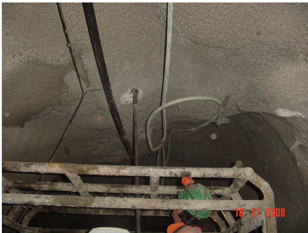
Fig. 4.16: Instalación pernos en túnel mina El Teniente.
