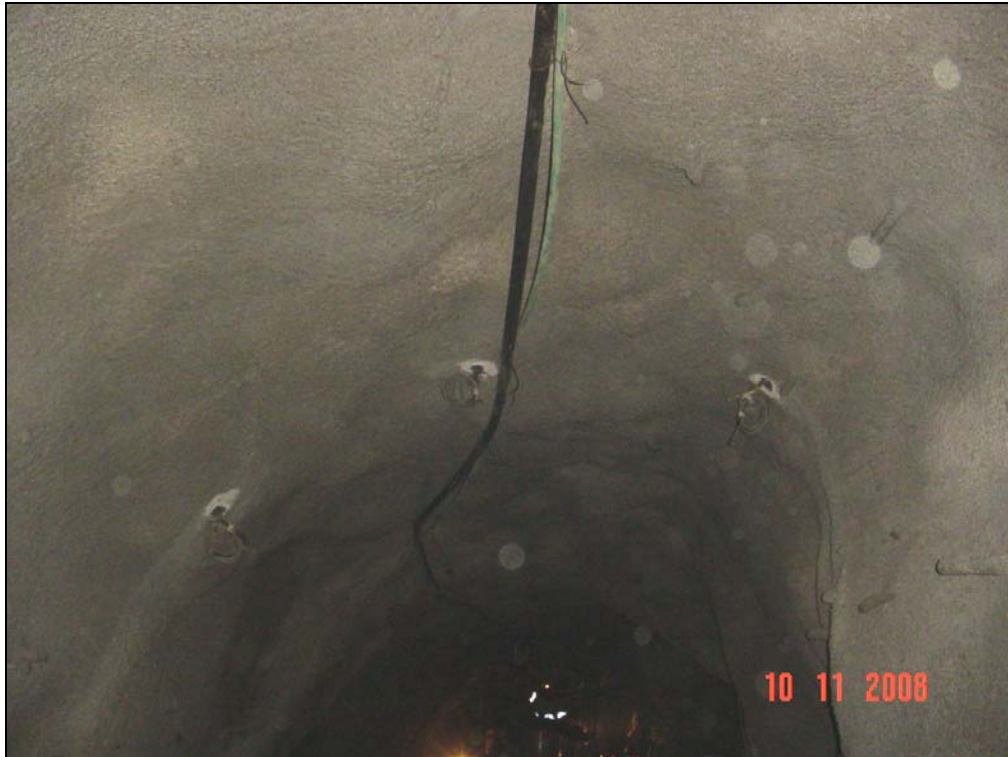
Fig. 4.18: Túnel con pernos instrumentados con fibra óptica en nivel de hundimiento mina El Teniente.
