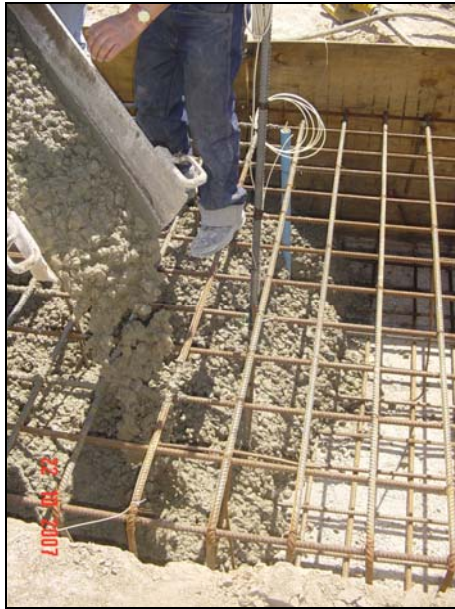
Fig. B. 3: Hormigonado losa. Vista 2.
