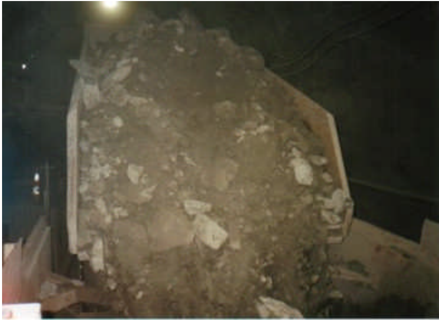
Figura 26: Camión descargando sobre el apron feeder.
