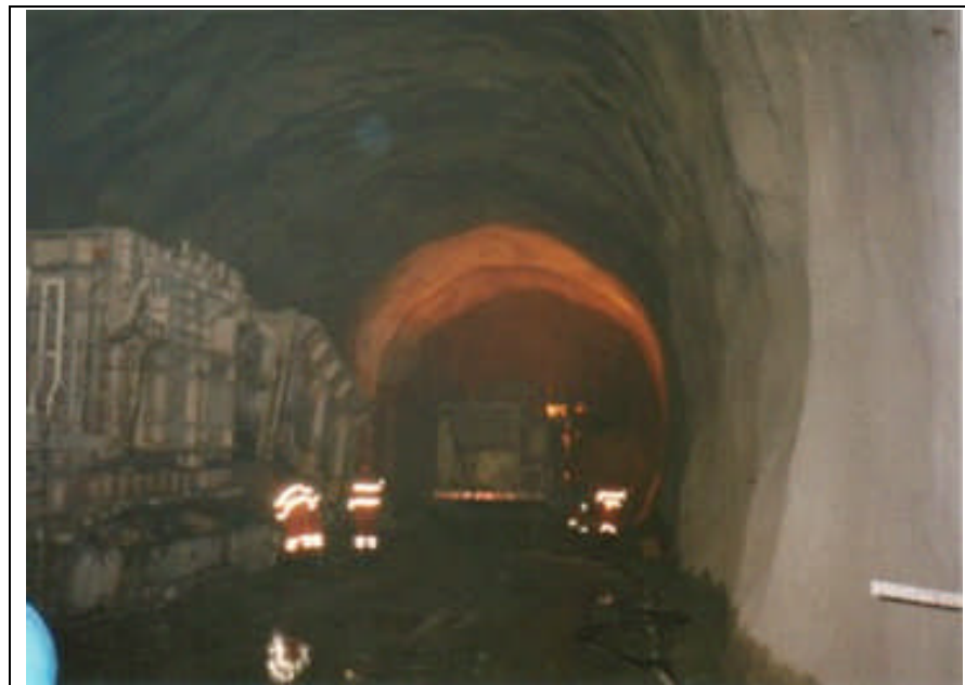
Figura 23: Sizer móvil en frente de trabajo.
