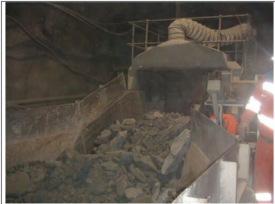
Figura 27: Apron feeder del mineral sizer.
