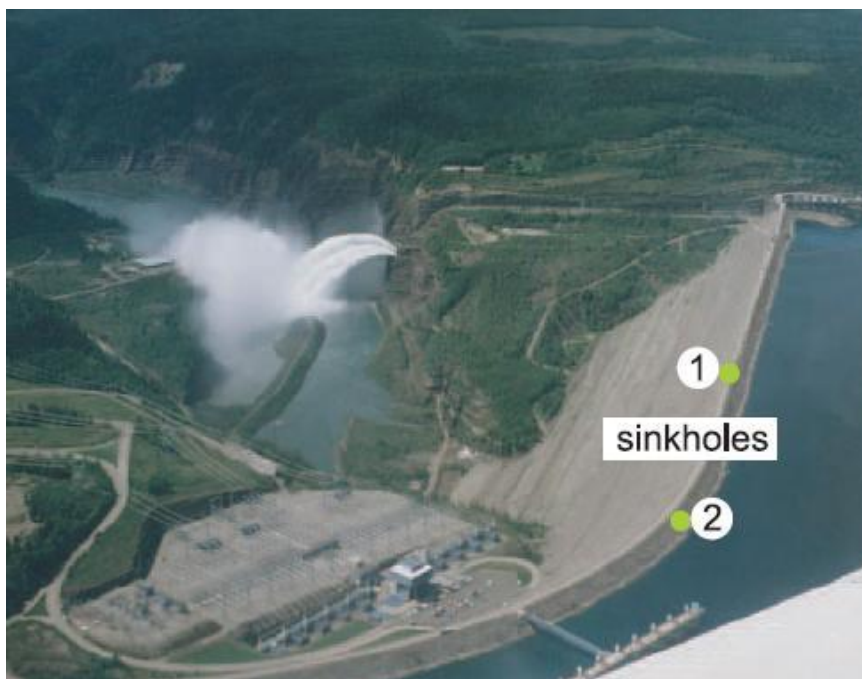
Figura 3.18: Distribución de las cavidades en la represa WAC Bennett (Wood, 2005)
