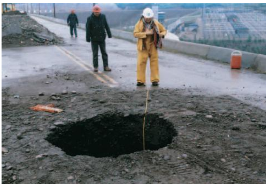
Figura 3.19: Cavidad 1 en la represa en WAC Bennett (Wood, 2005)
