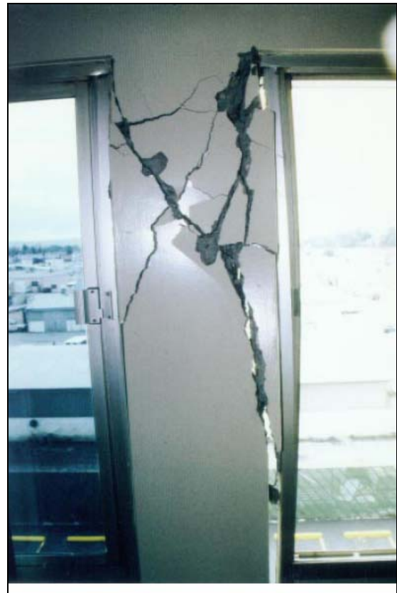
Figura 3.57 Daños en columnas del eje A del edificio Holiday Inn durante el terremoto de Northridge. (Trifunac y Hao, 2001)
