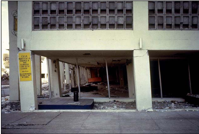
Figura 2.13 Daño en las columnas del edificio Mi Casa durante el terremoto de Managua 1972.
