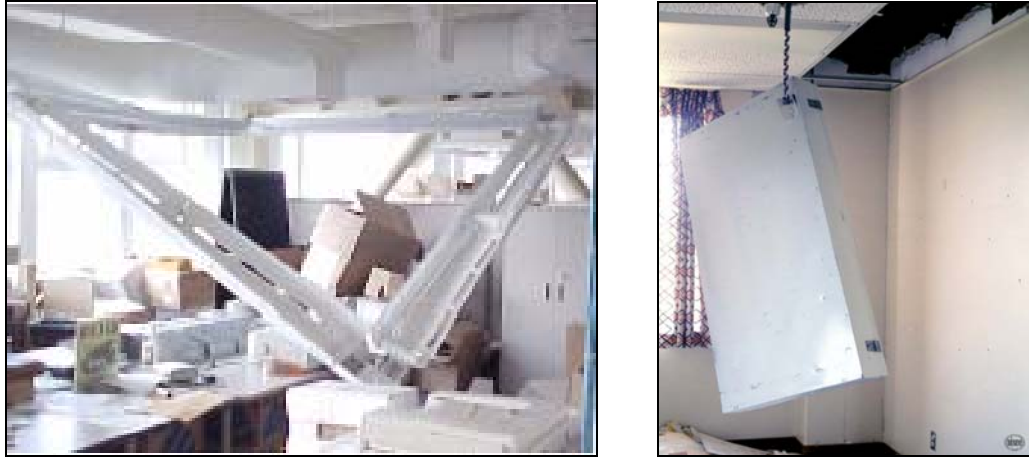
Figura 2.26 Falla en sistema de iluminación.
