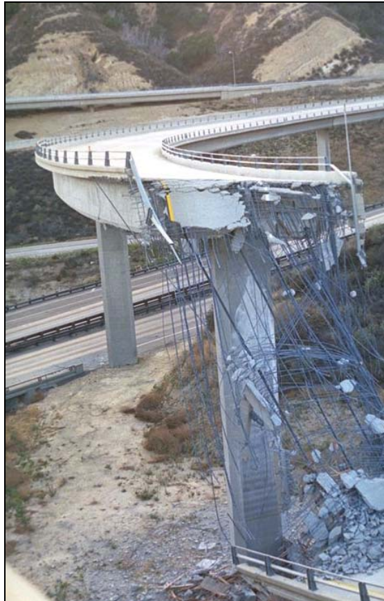
Figura 3.55 Colapso de un puente durante el terremoto de Northridge 1994.
