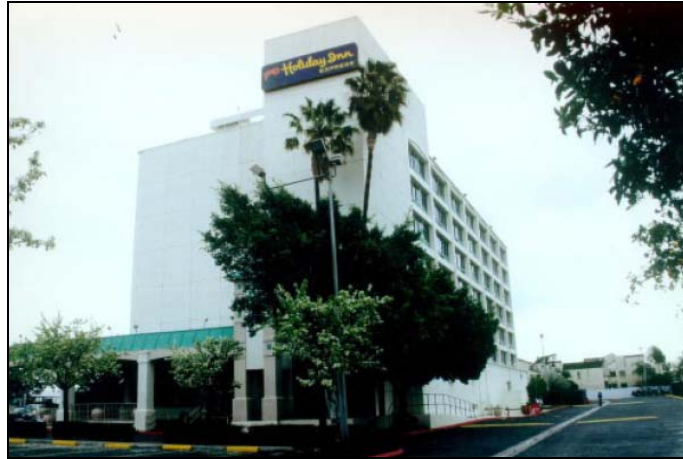
Figura 3.3 Edificio Hotel Holiday Inn.
