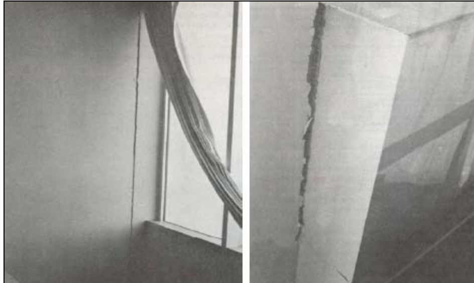
Figura 3.74 Falla en unión de tabique del edificio Bank of California durante el terremoto de San Fernando 1971 (NOAA, 1973).
