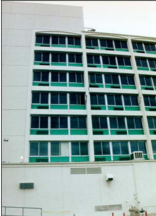
Figura 3.56 Daños en el eje A del edificio Holiday Inn durante el terremoto de Northridge. (Trifunac y Hao, 2001)
