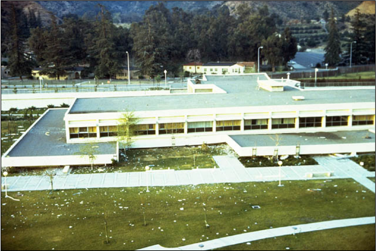
Figura 3.71 Colapso de la unidad psiquiátrica del hospital Olive View, terremoto San Fernando 1971.
