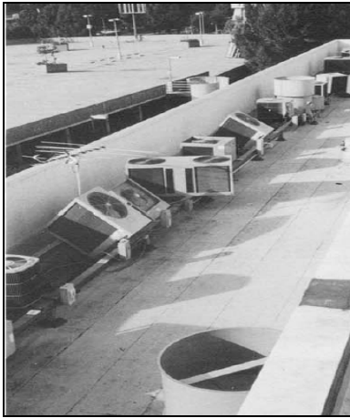
Figura 2.30 Falla en equipos durante los terremotos de Northridge (izquierda) y San Fernando (derecha).
