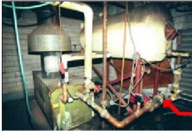
Figura 2.32 Ruptura de cañería de estanque de almacenamiento de agua. Sala de máquinas, techo Hotel Ramada Inn, Olympia.
