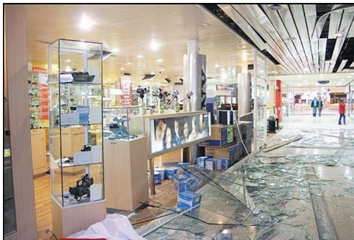
Figura 2.29 Daño en vitrinas de un local comercial durante el terremoto de Tarapacá.
