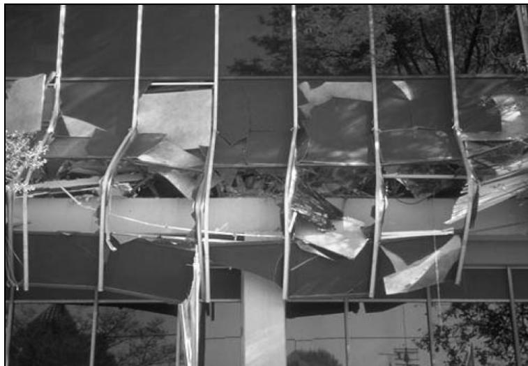
Figura 2.27 Falla en muros cortina.
