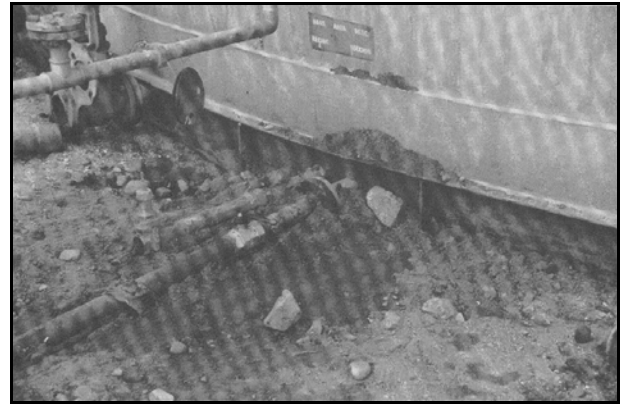
Figura 3.44 Daño en tuberías debido al asentamiento de un tanque de agua (EERI, 1986).
