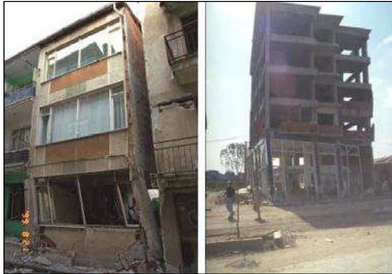
Figura 2.17 Fallas de las columnas del primer piso durante el terremoto de Izmit, Turquía 1999.
