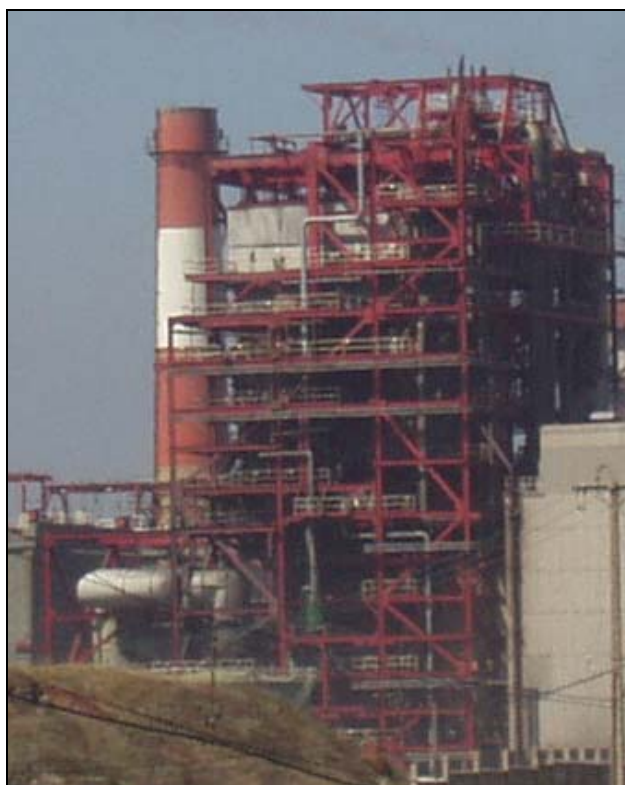
Figura 3.2 Estructura de la caldera colgante Central Termoeléctrica Ventanas II.
