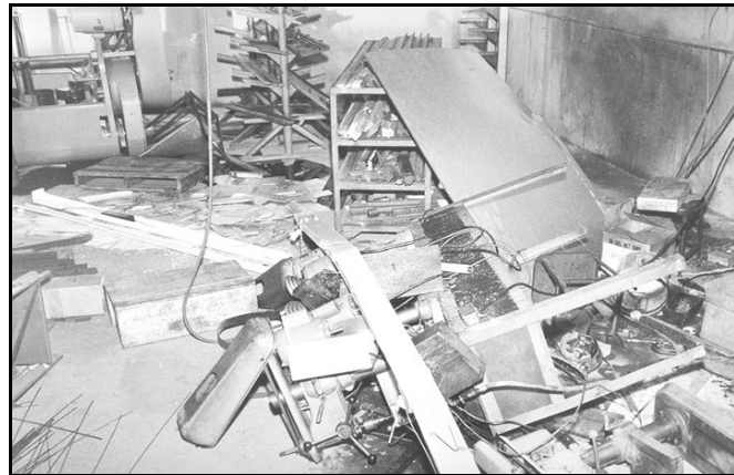
Figura 2.19 Caída de contenidos y volcamiento de equipos durante el terremoto de San Fernando 1971.
