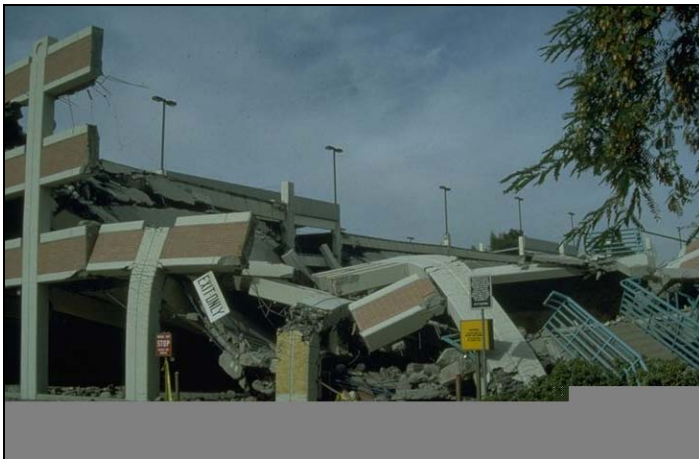
Figura 2.15 Colapso de estructuras durante el terremoto de Northridge 1994.
