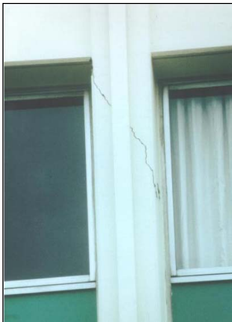
Figura 3.58 Daños en columnas del eje D del edificio Holiday Inn durante el terremoto de Northridge. (Trifunac y Hao, 2001)
