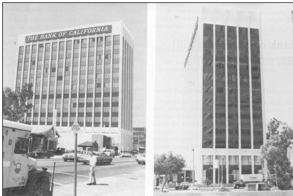
Figura 3.19 Edificio Bank of California (NOAA, 1973).
