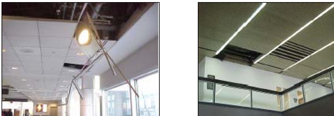
Figura 2.25 Daño en sistemas de cielo.
