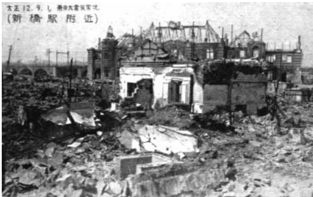
Figura 2.2 Daño en la ciudad de Tokyo durante el terremoto de Kanto 1923 (Bozorgnia y Bertero, 2004).
