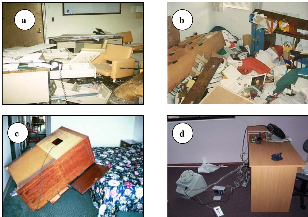
Figura 2.23 Daño en el mobiliario de edificios durante los terremotos de: a) San Fernando, b) Northridge, c) Nisqually y d) Tarapacá.
