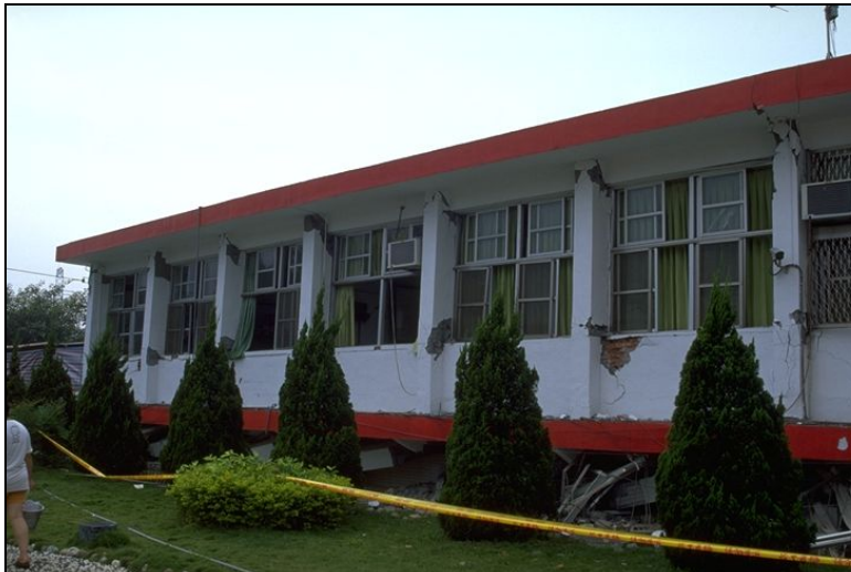
Figura 2.18 Colapso del primer piso de dos edificios durante el terremoto de ChiChi, Taiwán 1999.
