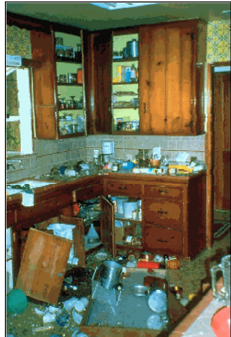
Figura 2.21 Daño en los contenidos de una cocina durante el terremoto de Northridge (izquierda) y Loma Prieta (derecha).
