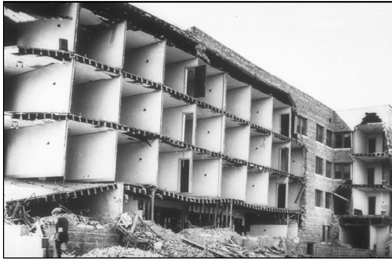
Figura 2.3 Daño Hotel California durante el terremoto de Santa Bárbara 1925 (Bozorgnia y Bertero, 2004).
