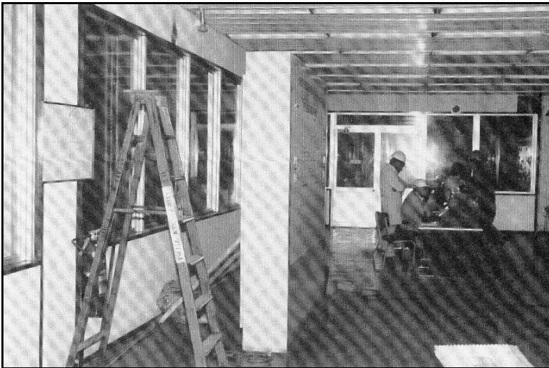
Figura 3.41 Ruptura de vidrios debido al impacto de un panel de control cuyos pernos de anclaje fallaron (EERI, 1986).
