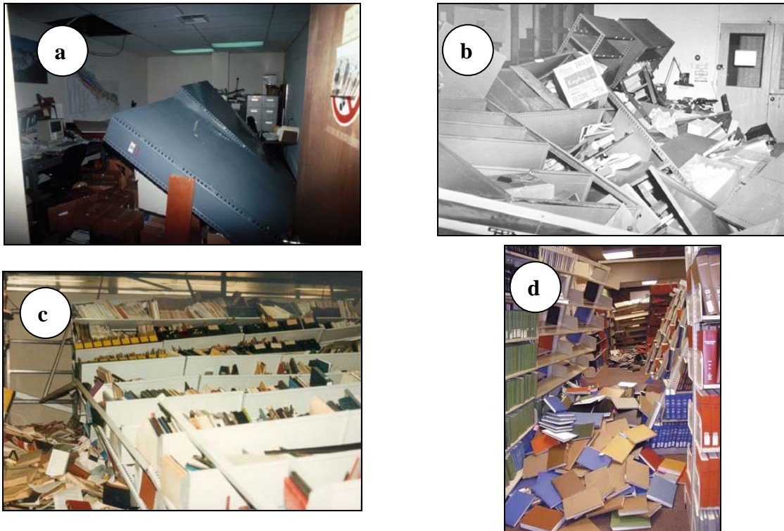
Figura 2.22 Daño de estanterías durante los terremotos de: a) Loma Prieta, b) San Fernando, c) Chile Central y d) Nisqually.
