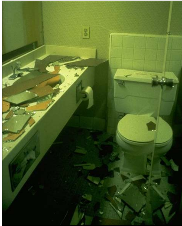
Figura 3.72 Daño no estructural en baño del hotel Holiday Inn durante el terremoto de San Fernando 1971.
