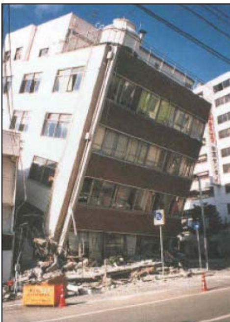
Figura 2.16 Colapso de dos edificios debido a la falla en el primer piso durante el terremoto de Kobe 1995.
