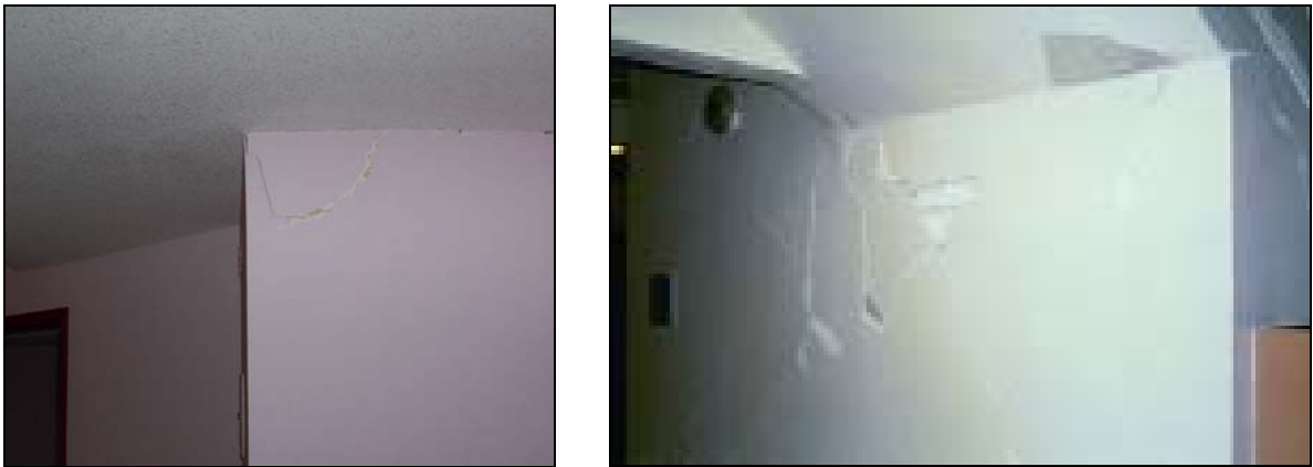
Figura 2.24 Daño en tabiques divisorios.
